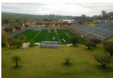
INÍCIO DA OBRA DO COMPLEXO ESPORTIVO
