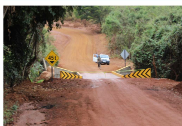
PONTE "TIA NEGA"
