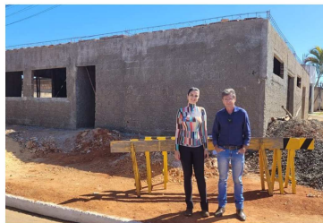
CENTRO COMUNITÁRIO NA COMUNIDADE DA ANTINHA
