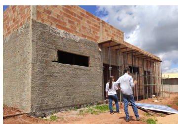
CENTRO COMUNITÁRIO NA COMUNIDADE DA PERDIZINHA
