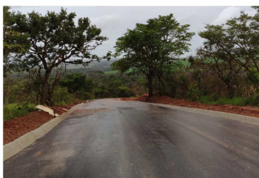
700m DE PAVIMENTAÇÃO NA SUBIDA DO RIO TAMANDUÁ
